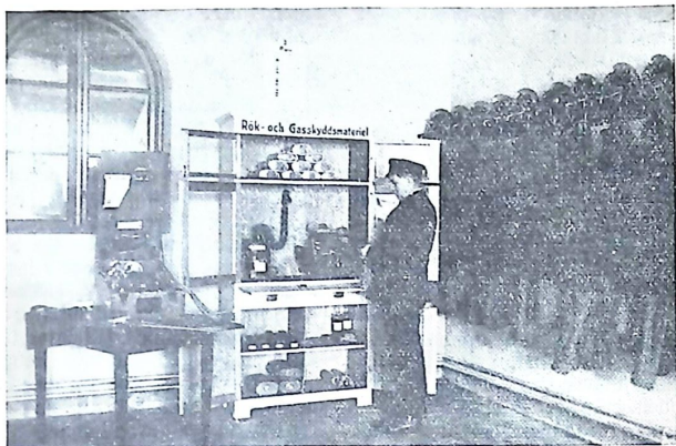
Bild 2. Skåpet är genom gummiplattor isolerat från det fuktiga golvet. Samtliga skåpdörrar hava tätningsslistor.
